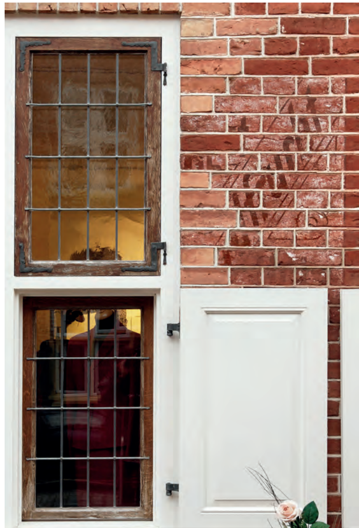
250 Fenster in der Mittelstraße 2008
