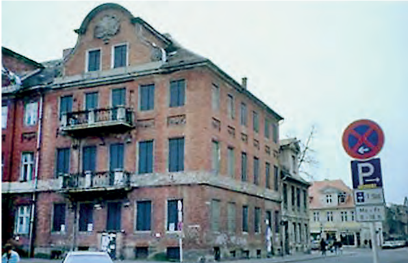
246 Haus Am Bassin 1 1995
