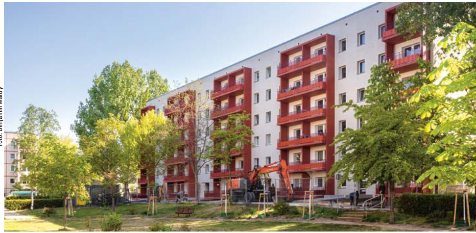
Mehr Energieeffizienz: Im Schlaatz werden, wie hier am Binsenhof bereits geschehen, die Gebäude nach und nach saniert.
